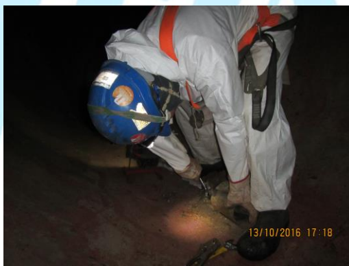
Imagen 13: "Instalación de Ánodos"
