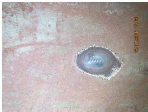
Imagen 10: "Reparación Ducto Sifón y Ducto Circulación Principal"
